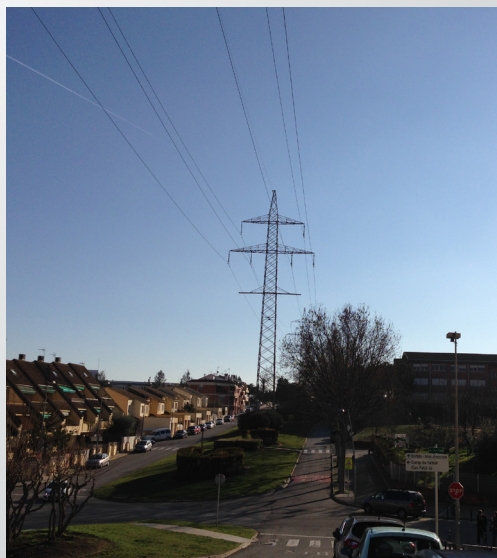
Línia elèctrica d'alta tensió de 220 KV a Can Fatjó. Fotografia: VR
